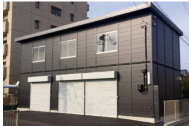
事務所兼倉庫 製品名/スタンダード
