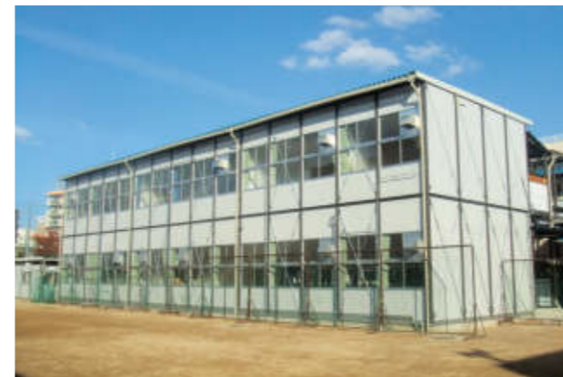
仮設校舎 製品名/スタンダード
